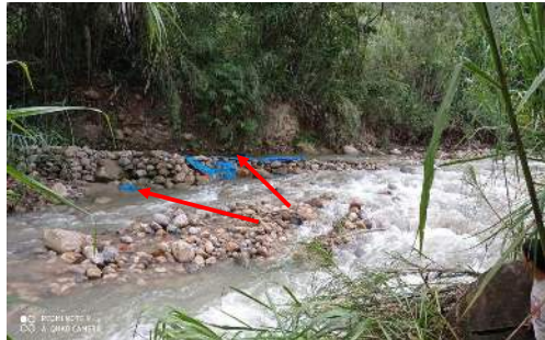
FOTOGRAFIA N°01: AFECTACION DE BOCATOMA DEL CANAL MICHINAL EN LA MARGEN DERECHA DE LA QUEBRADA PIALANA (QUEBRADA PIATANA).
